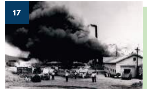
INCENDIE DU MOULIN, 1966
